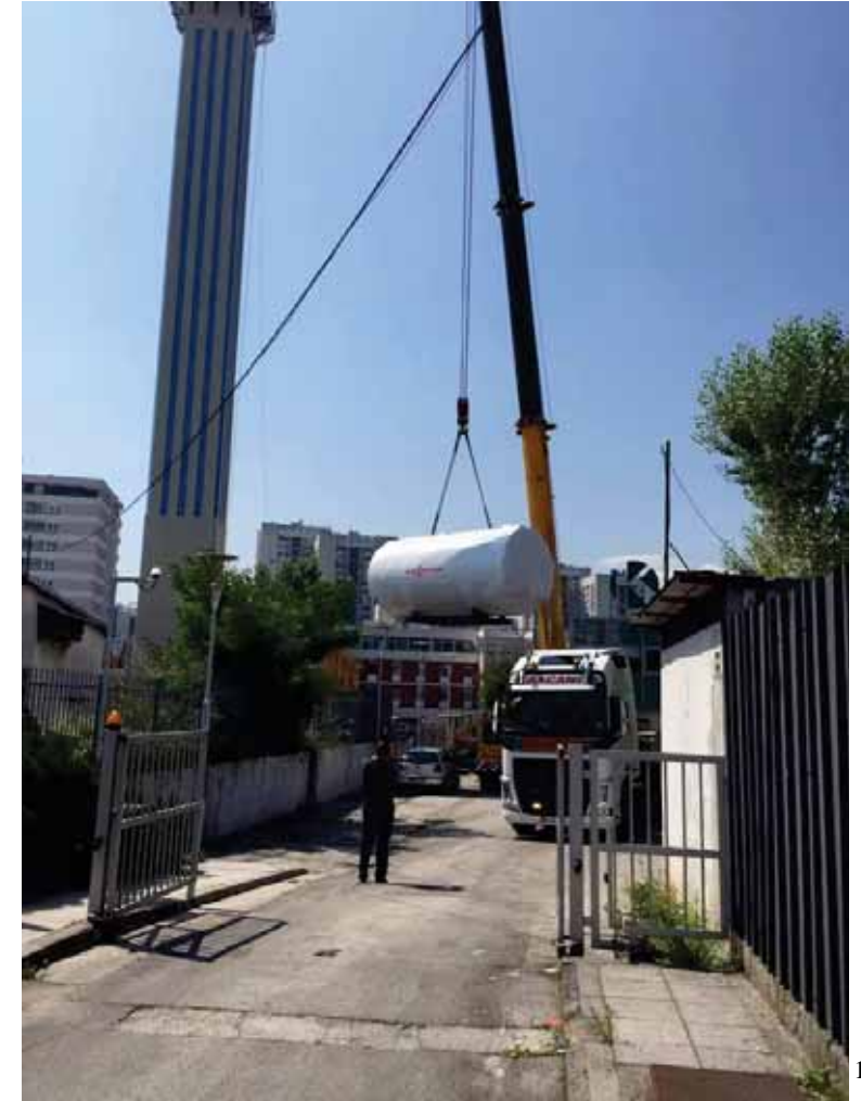
Unošenje kotlova – 16.07.2018.
