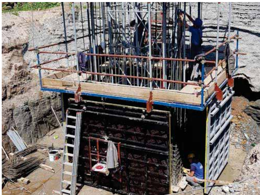
Prvi segment dimnjaka – 20.04.2018.
